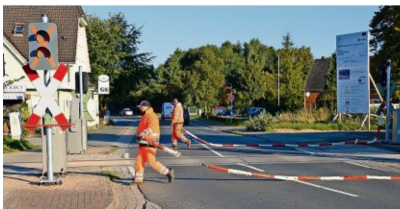
Mitarbeiter der Firma SiBB aus Brandenburg sperren den Bahnübergang in der Nordholzer Ortsmitte mit Flutterband ab. Foto Malekaitis
