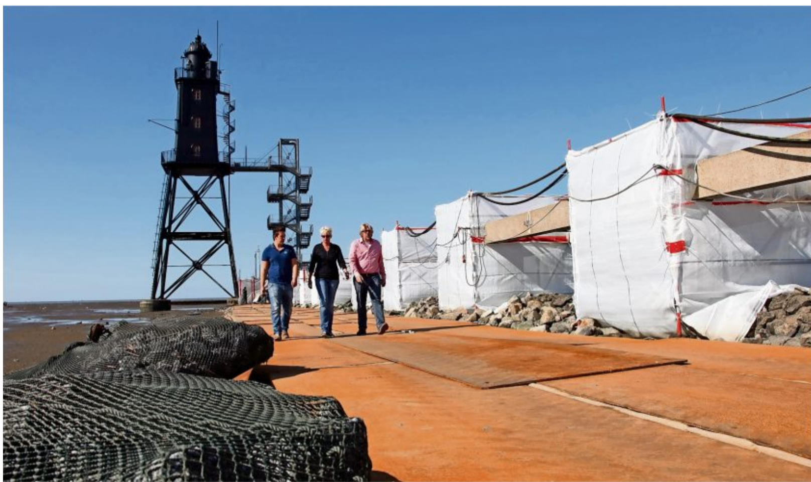
Brücken-Baustelleninspektion mit Architekten und Verwaltungsfachfrau (von links): Tobias Kayser, Norma Warncke, Wolfgang Kayser. Fotos (2) Leuschner
