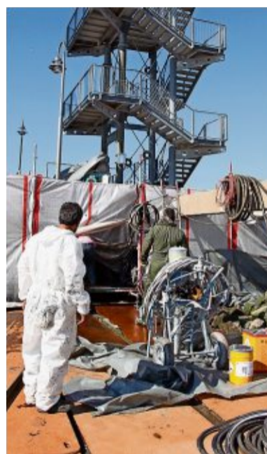
Korrosionsschutz: Mit Hochdruck entfernen Arbeiter die Verwitterungsschäden an der Spundwand.
