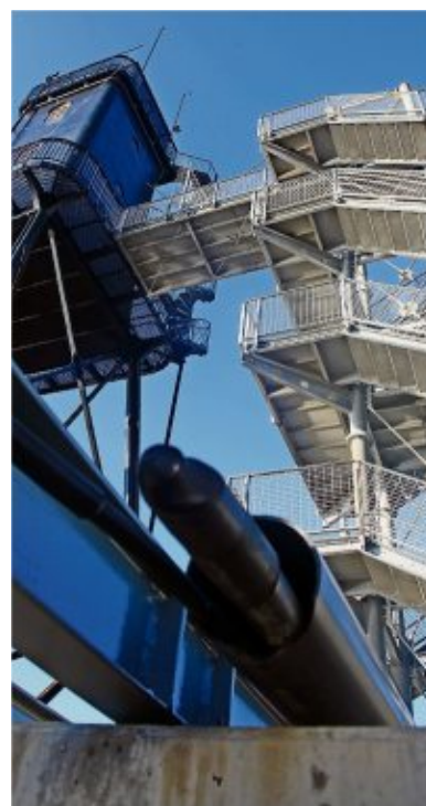
Mit den Stahlträgern werden auch die Versorgungsleitungen zum Turm neu verlegt.
