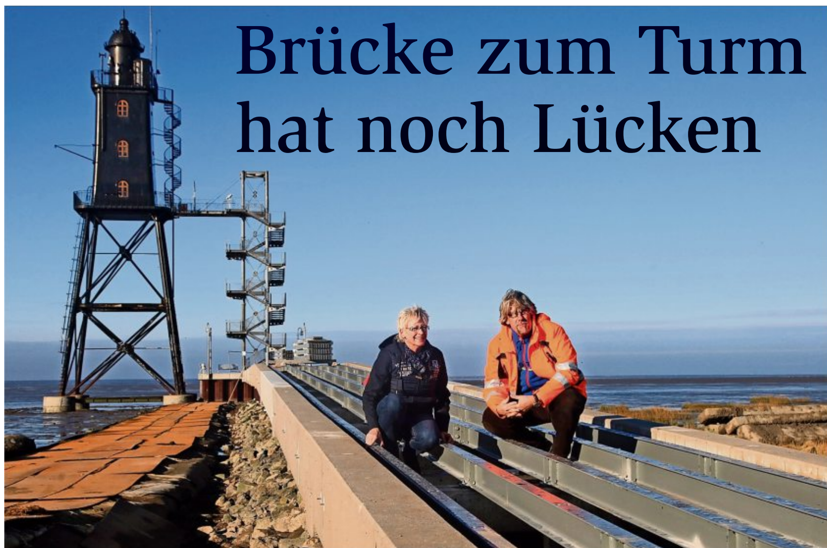
Die Baustraße (links) zum Obereversand ist bald Geschichte. Bauamtsleiterin Norma Warncke und Architekt Wolfgang Kayser warten auf die Geländer und die Gitterroste für die frisch sanierte Brücke zum Leuchtturm am Dorumer Tief.
