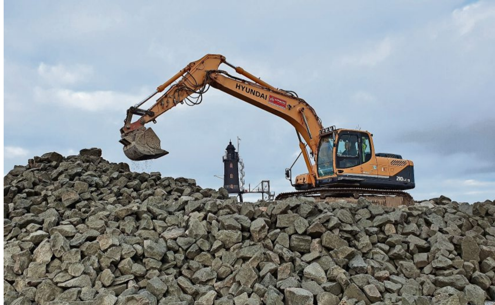
Ein Bagger schichtet Wasserbausteine auf der Leuchtturmwiese in Dorum-Neufeld auf. Das Material soll im Frühjahr verbaut werden. Fotos: Leuschner
